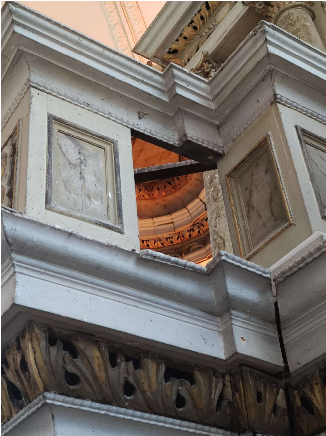
Neišlikusi baliustrados pjedestalo plokštuma
