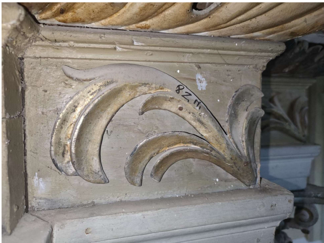
Antro tarpsnio drožtinis elementas. Drožinys sidabruotas, dengtas ausksaspalviu laku. Lakas praradęs spalvos intensyvumą, sidabruotė pradėjusi oksiduotis
