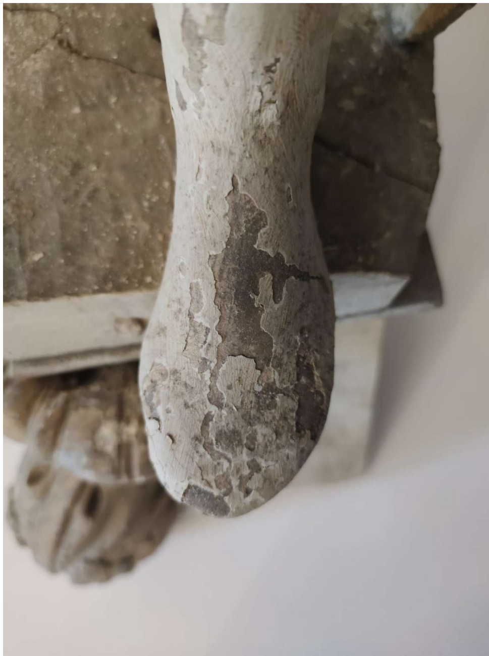
6 il. Trupantis, birus grunto sluoksns kairios pėdos paviršiaus plote
