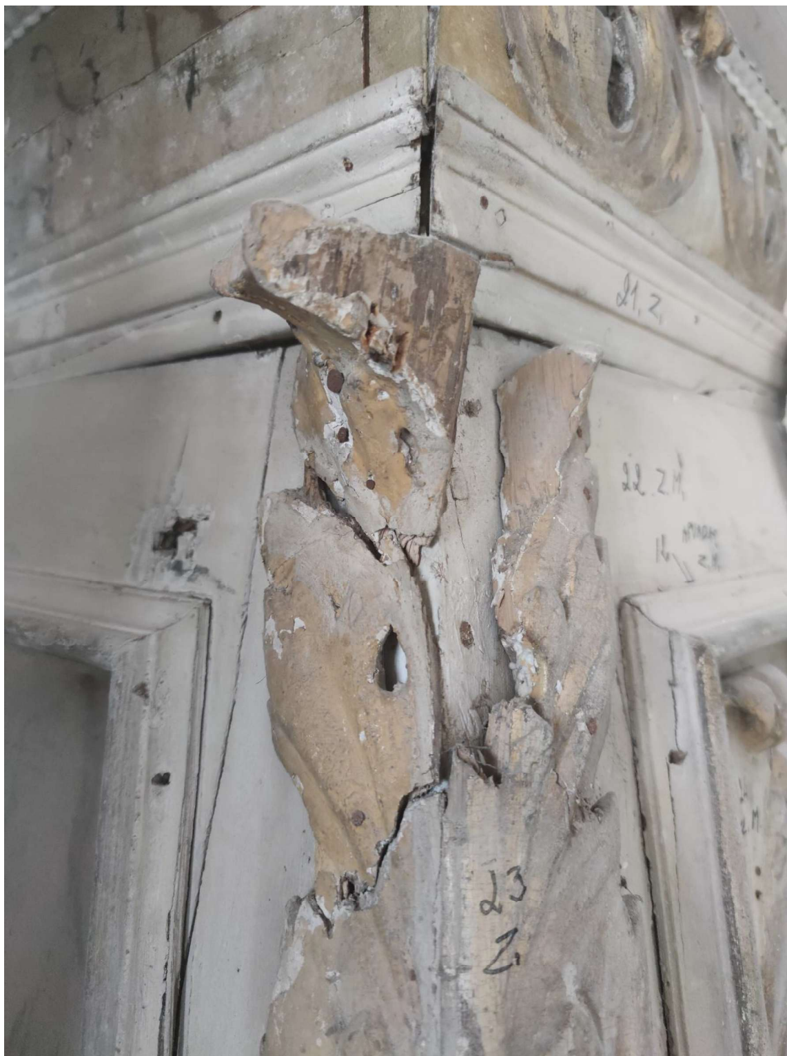
Aplūžē drožtieši postamento dekoru elementai. Konstrukcijas sujungimo vietose atsiradę tarpai
