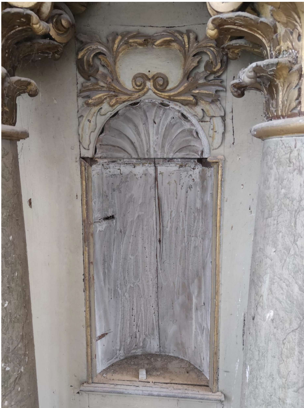
Pirmo tarpsnio niša. Nišos lentos neautentiškos, pakeistos ankstesnio resturavimo metu. Virš kriauklainio esantis drožtinis elementas purvinas, nešvarus, vietomis padengtas aliejiniais dažais
