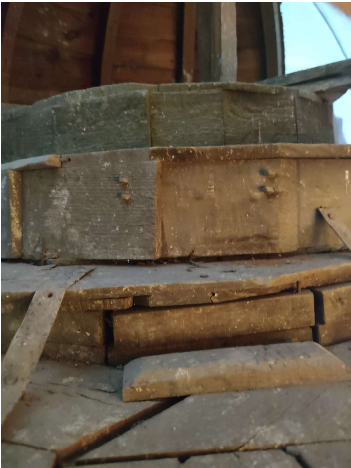
Kupolo konstrukcija iš nugarinės pusės. Atsiradę dideli tarpai lentų sujungimo vietose
