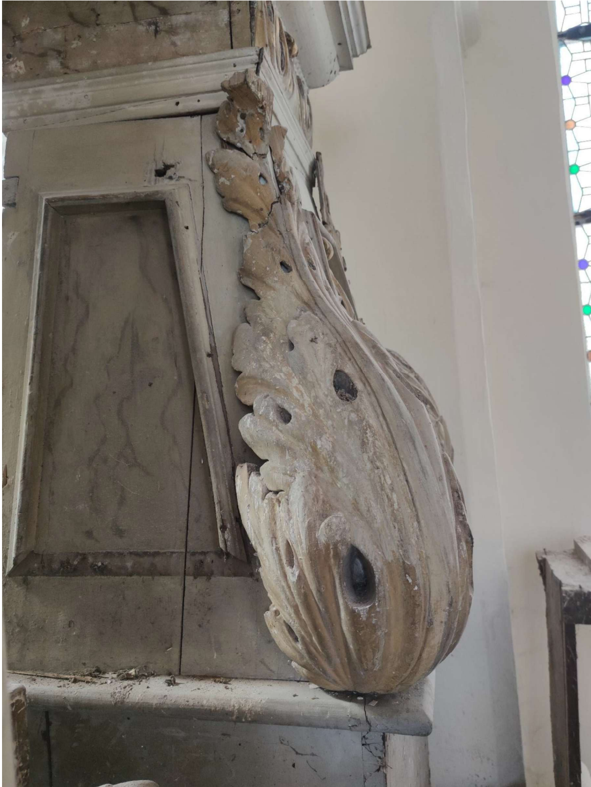
Aplūžęs, apskeldėjęs, storu buitinių nešvarumų sluoksniu pasidengęs postamentas
