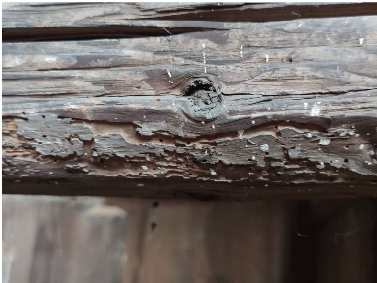
Konstrukcija, pažeista medžio entomologinių kenkėjų
