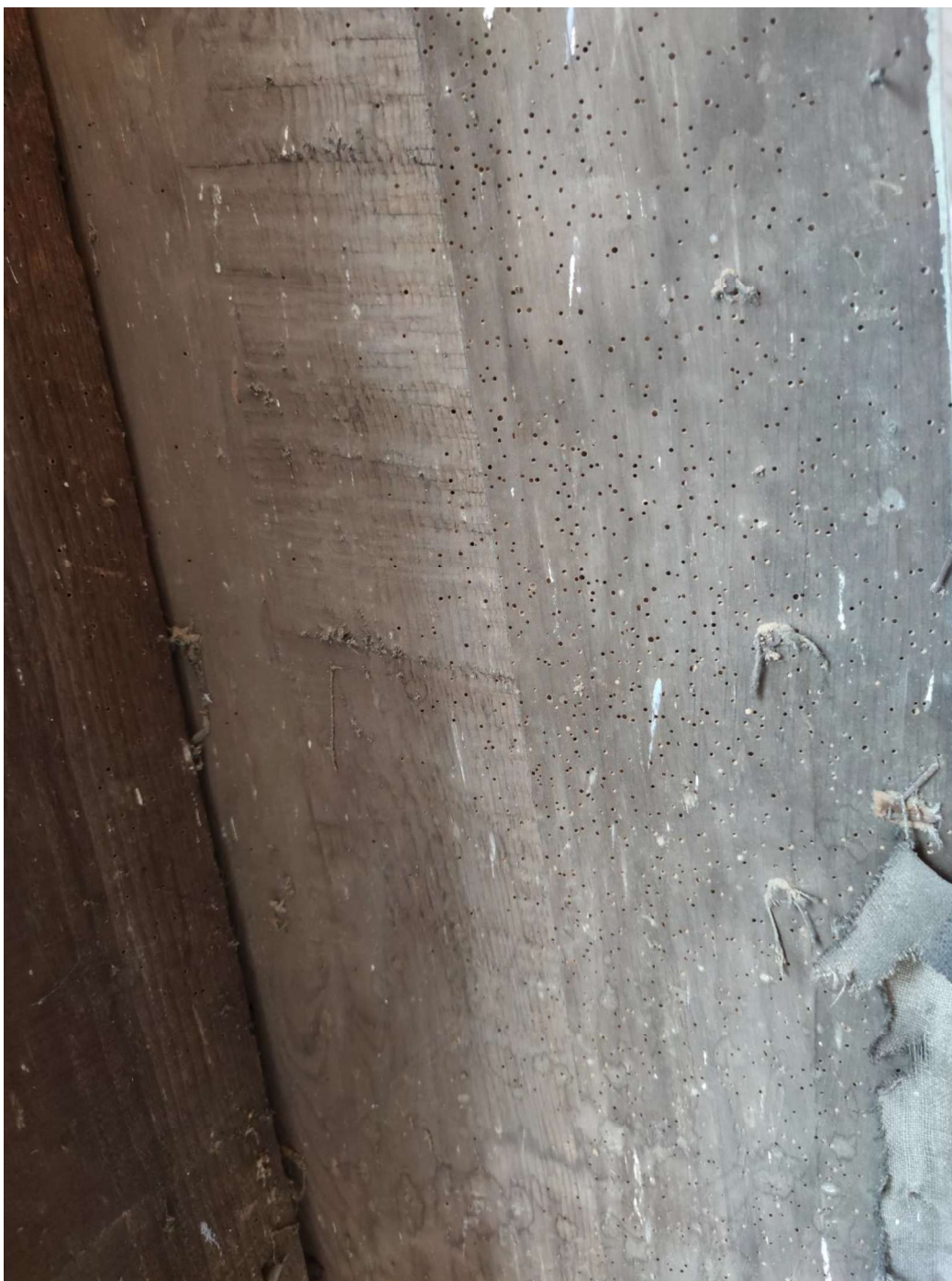
Nugarinė altoriaus pusė. Matomi medžio entomologinių kenkėjų sukelti pažeidimai
