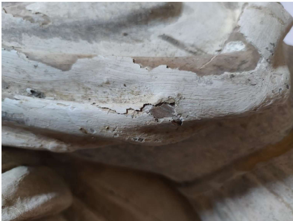
7 il. Atsšokę nuo pagrindo grunto fragmentai drabužio kolsčių paviršiuje
