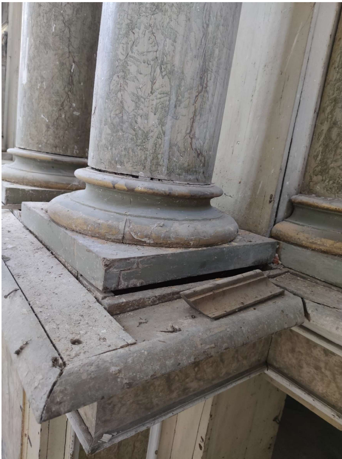
Aplūžęs, suskeldėjęs, gausiu nešvarumų sluoksniu pasidengęs altoriaus retabulo konstruktyvas
