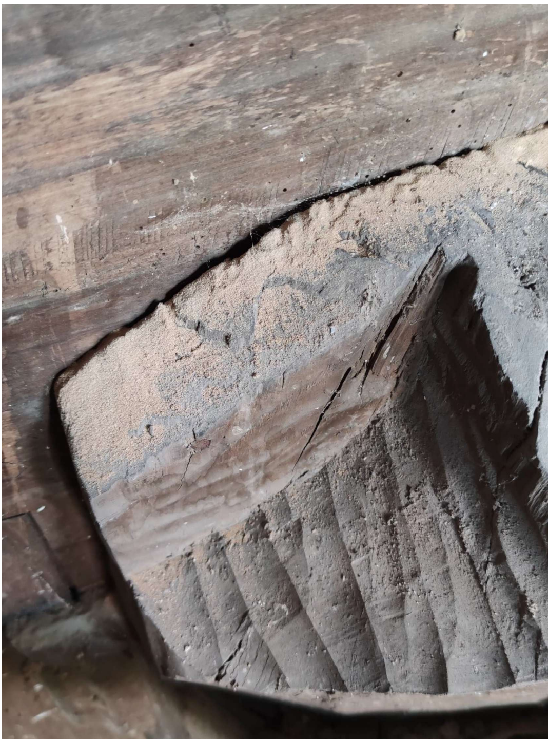
Konstrukcijos mediena vietomis paversta į miltus
