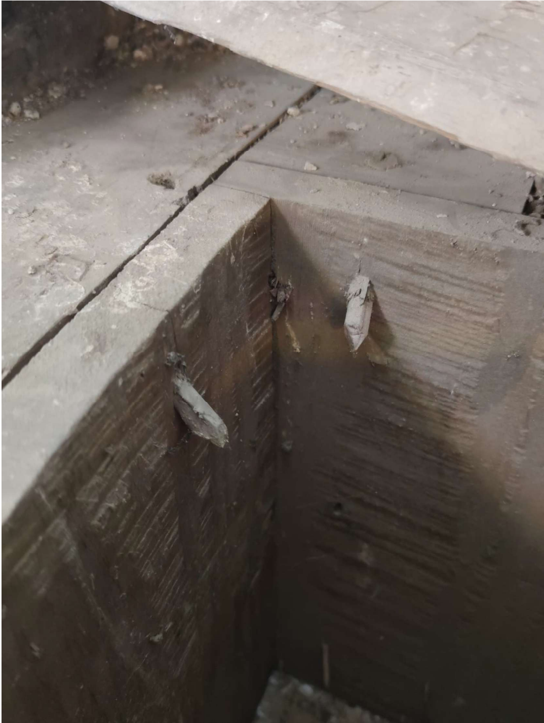
Autentiškas konstrukcijos tvirtinimas mediniais dygiais
