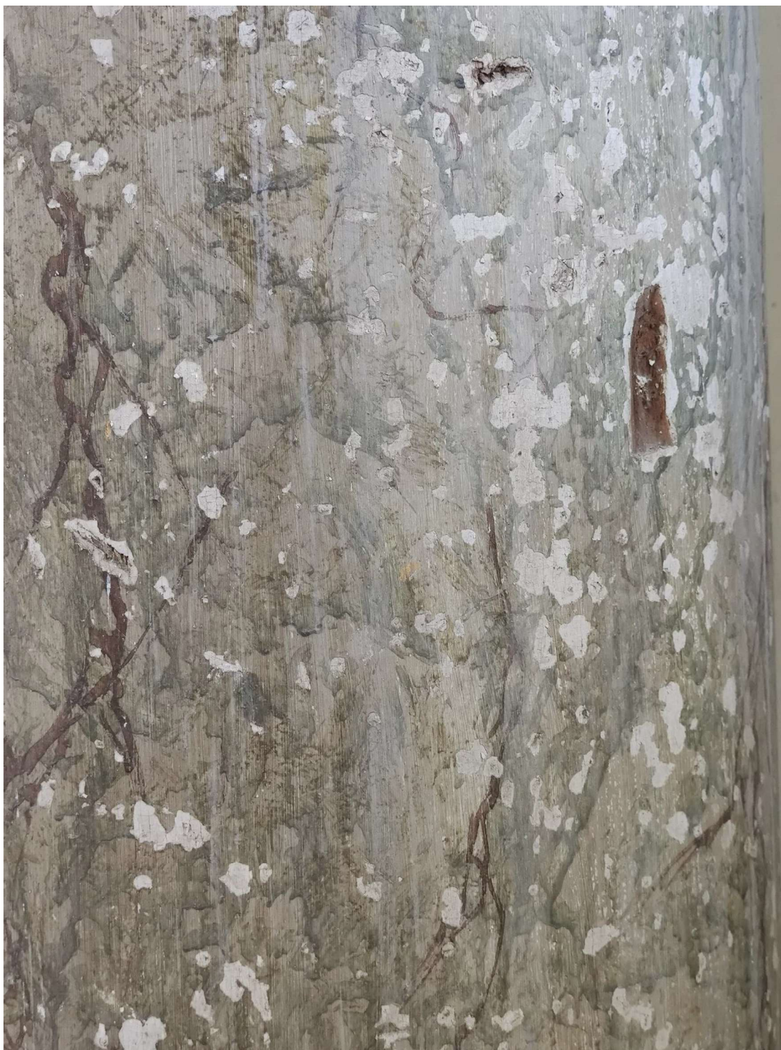
Kolonos stiebo dekoratyvinė danga. Autentiškas grunto sluoksnis praradęs rišamąją medžiagą, vietomis atšokęs nuo pagrindo
