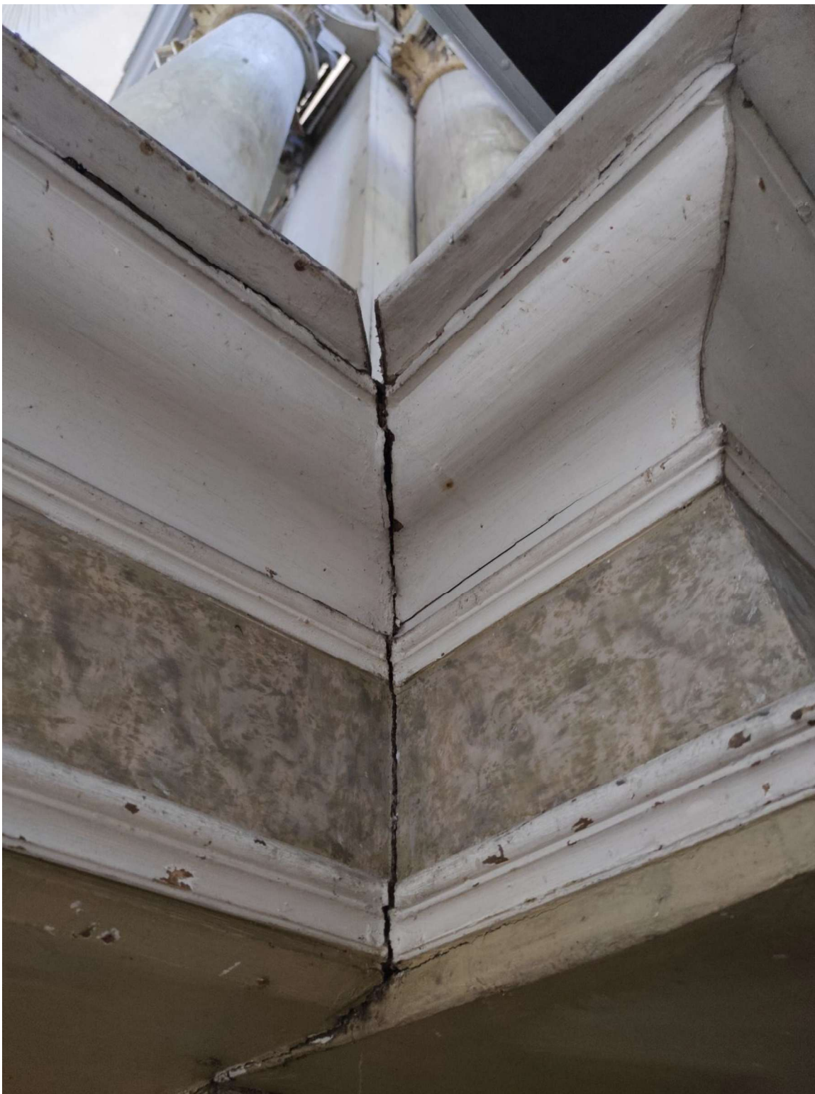
Trūkis konstruktyvo sujungimo vietoje
